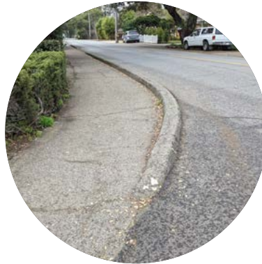
ASPHALT BERM
