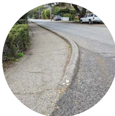
ASPHALT BERM
